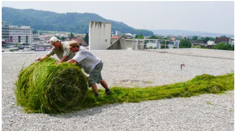
Ein Dach wird mit Heugras begrünt.
