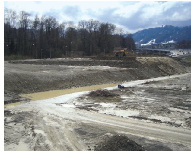
Entlang der Autobahn wurde ein Lärmschutzwall aufgeschüttet und mit Kiessand der Sihl bedeckt.
