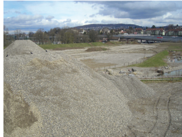
In der Vergangenheit wurde die Allmend Brunau als Baustelleninstallationsgelände für SBB- und Uetlibertunnel genutzt.
